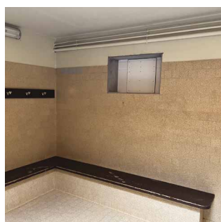
12 Travaux des vestiaires du gymnase
