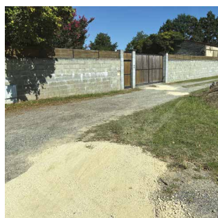
8 Travaux d'empierrement (ici Route Pomiro)
